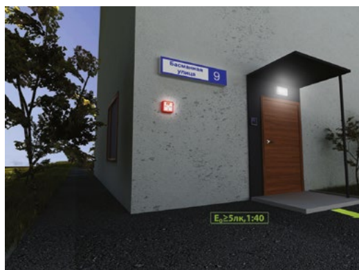
снаружи перед каждым конечным выходом из здания
