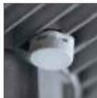
Клапан выравнивания давления
